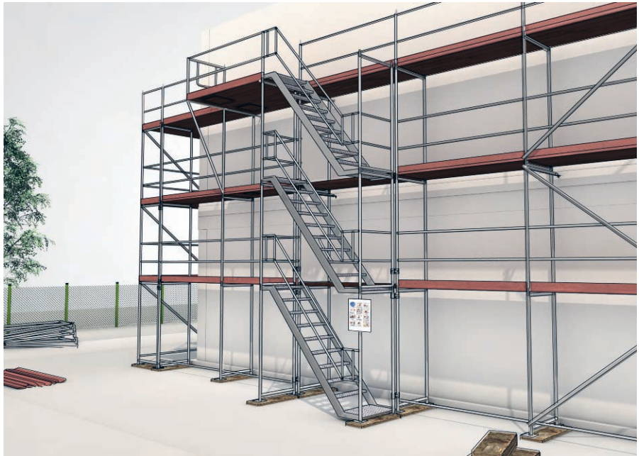
Bild 8: Gerüst mit Gerüsttreppe als Zugang
